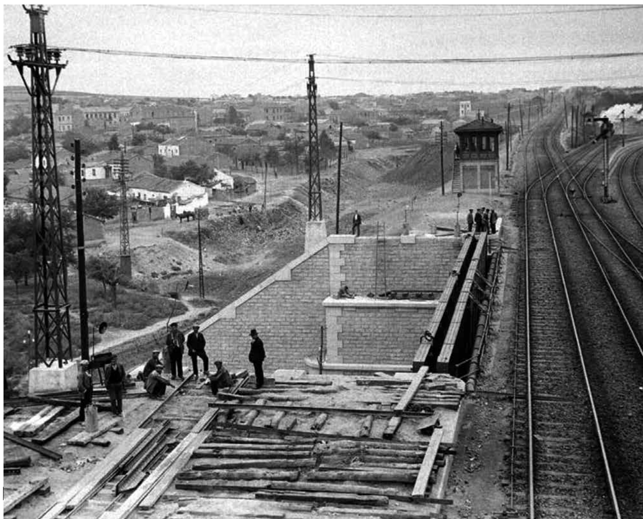
1928. Obras ampliación Puente de los tres ojos sobre Arroyo Abroñigal (Madrid)
